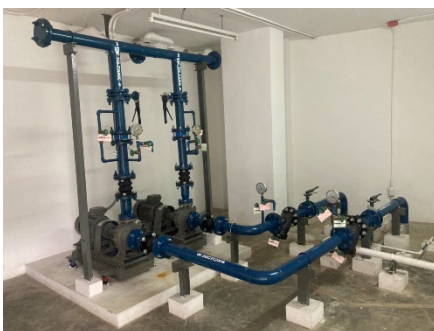
ภาพที่ 2-10 ระบบน้ำใช้โครงการ
